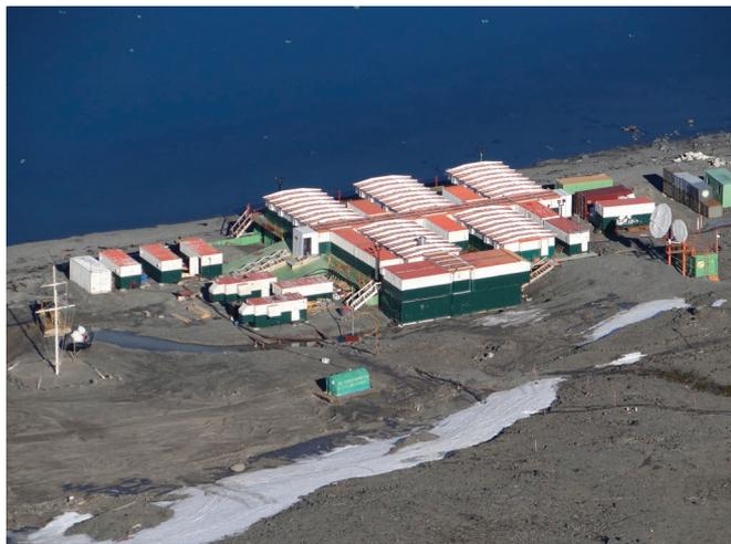
Imagem dos Módulos Antárticos Emergenciais, geradores e Estações de Tratamento de Esgoto à esquerda, corpo principal construído sobre o antigo heliponto ao centro, à esquerda o incinerador, seguido pelo módulo de aquários, oficina, Laboratório Multiuso e Laboratório de Química. Foto: Tânia Zaleski.
